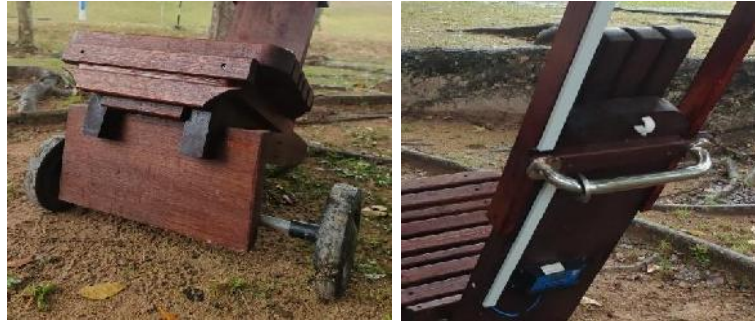
Rajah 7 : Roda dan pemegang untuk memudahkan pergerakan
